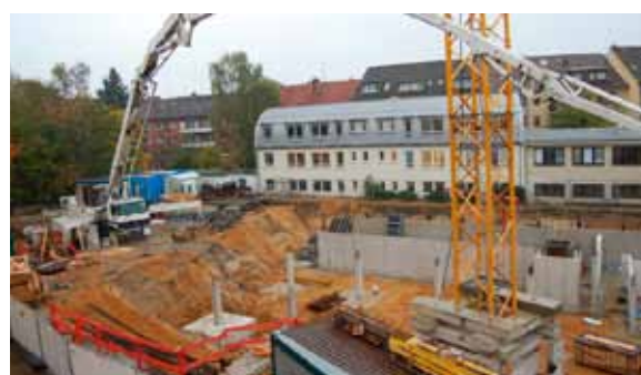
Mitten in Eilbek entstehen eine Bewegungskita und 24 Wohnungen.
